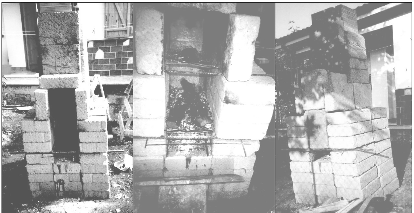
Fotos 1-3: Bauweise des Mattognoschen Kremierofens.
