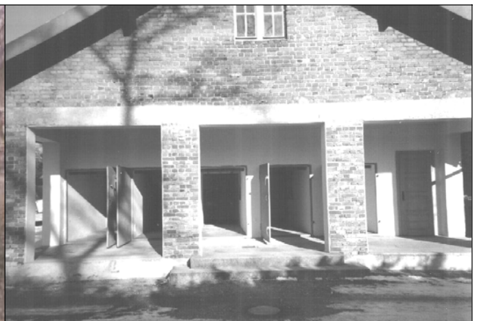
Abb. 6: 5 Degesch-Kreislauf-Entlausungskammern im Hygienegebäude des vormaligen KL Dachau.
